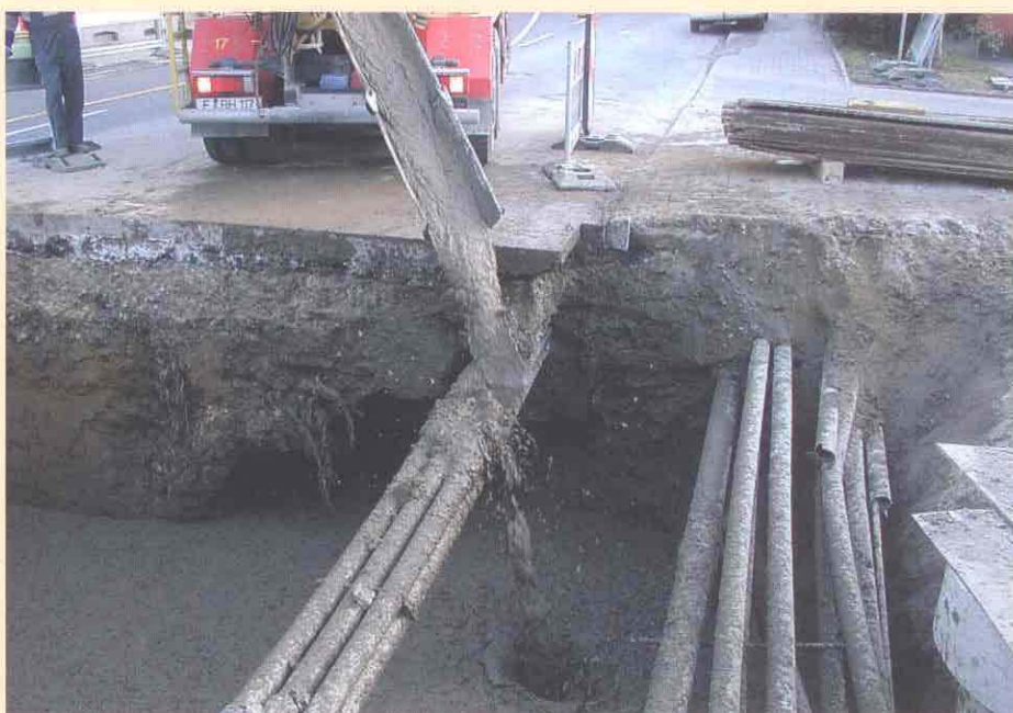
Bild 1: Einbringen des Flüssigbodens durch Transportmischer
