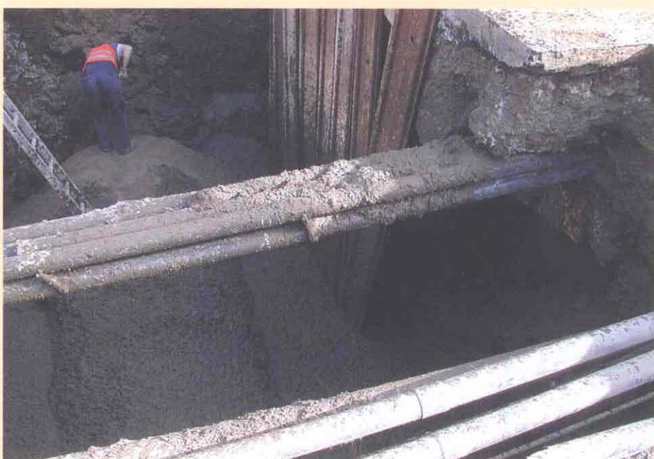
Bild 2: Verfüllung des Kanalgrabens und der Hohlräume im Bereich der Hauptverkehrsstraße und Versorgungsleitungen
