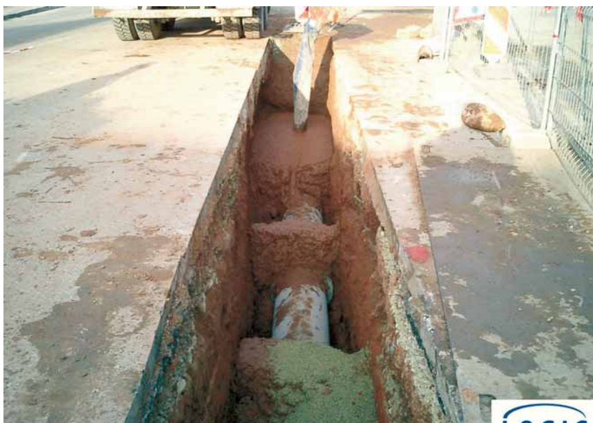
Bild 2 ■ Hohlraumfreie Verfüllung in der Straße.
