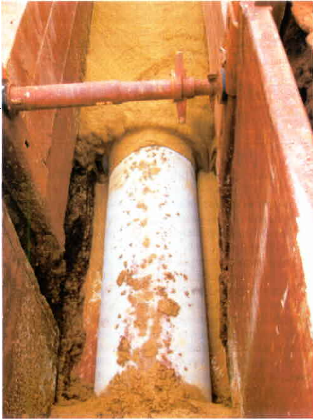
Rys. 3. Zalewanie przewodów czasowo upłynnionym gruntem wg technologii RSS-FB
