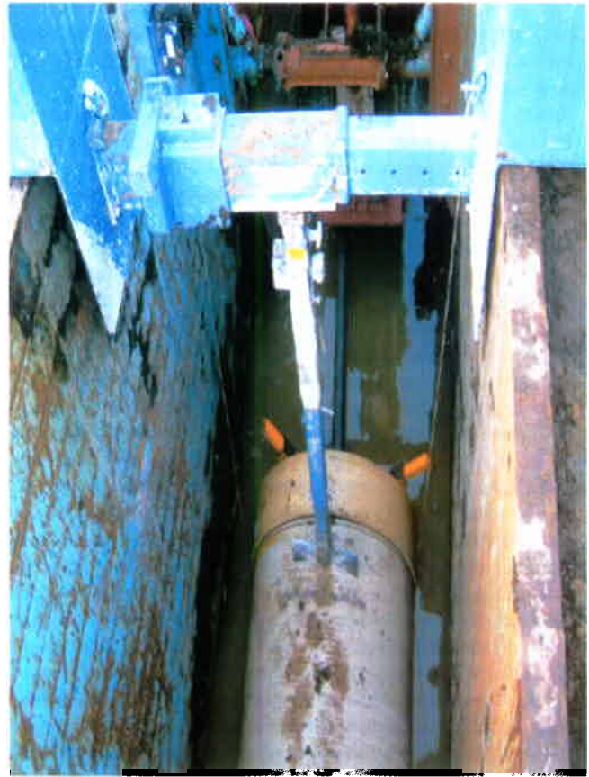
Rys. 4. Zastosowanie kompensatorów do przeciwdziałania wyporowi przewodów
