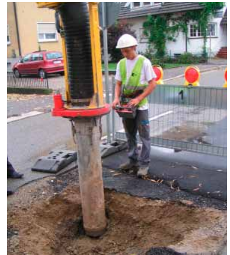
Saugbagger im Einsatz.
