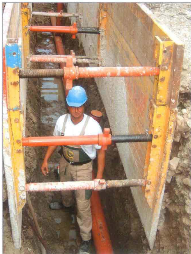
In Witterda wurde mit einem neuartigen Verfüllverfahren und dem Polo-Eco plus-Rohrsystem absolutes Neuland betreten. Fotos (4): FB-ARCHIV
