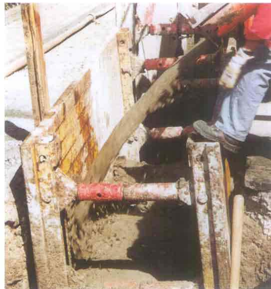
Einbringen des Flüssigbodens
