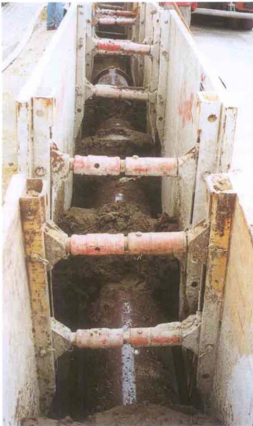
Fixieren der Rohre durch Haltungskegel
