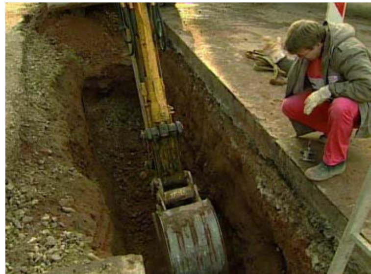
Graben für Entsorgungskanal
