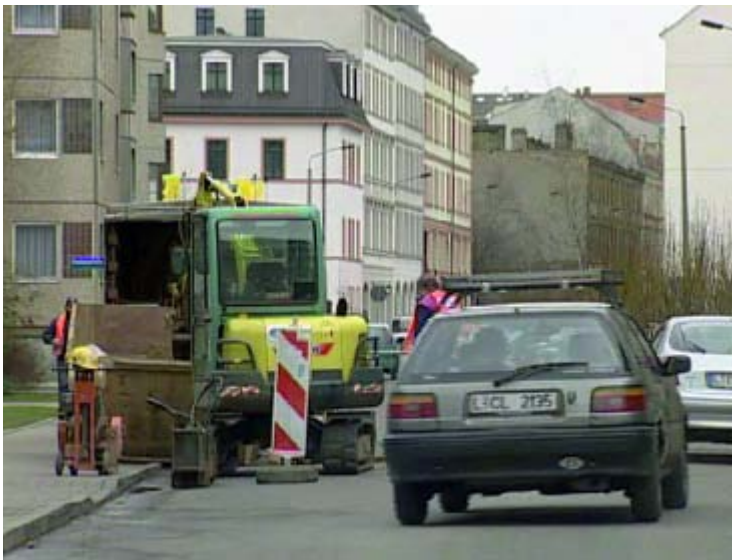
Baustelle behindert Verkehr
