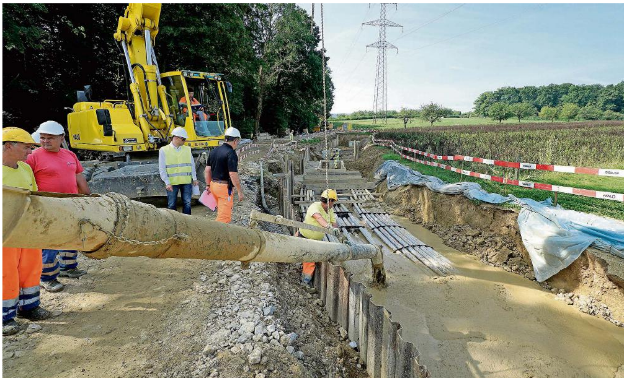
Flüssiger Boden sieht bei der Verarbeitung aus wie Beton, verfestigt sich aber hinterher zu normalem Boden, der sich dicht an die Rohre anschmiegt.
