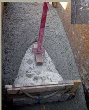
Der RSS-Flüssigboden umschliesst das neue GFK-Abwasserrohr nahtlos von allen Seiten (Franz Landolt).
