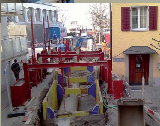
Hier geht es eng zu: die Baustelle im Lachner Dorfkern (FiFB Leipzig).
