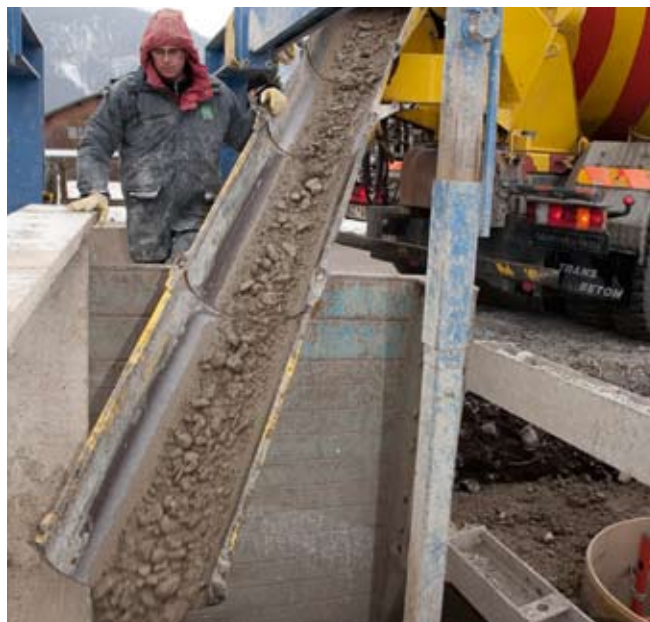
Ausgehobener Boden wird durch ein einfaches Verfahren zeitweise fließfähig gemacht.
