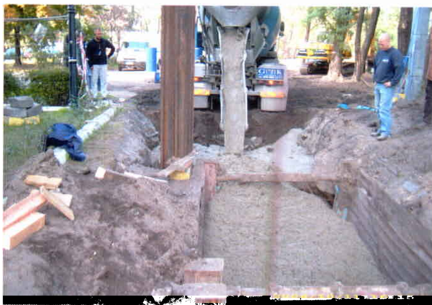
Fot. 3 Wypełnianie wykopu przy użyciu czasowo uptynnionego gruntu
