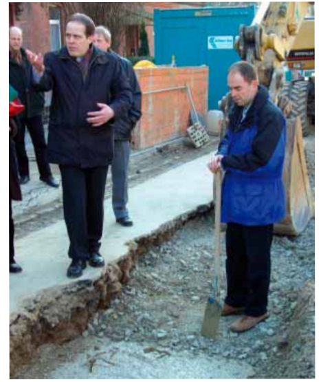
Ottmar Schneider informierte in seinem Vortrag und vor Ort auf der Baustelle über die Erfahrungen in Göttingen mit dem Einsatz von Flüssigboden.
