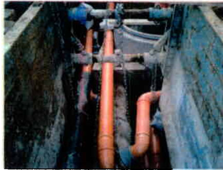
Bild 1: Typische Einbausituation und Anwendung von RSS-Flüssigboden
