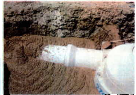
Bild 1: Typische Einbausituation und Anwendung von RSS-Flüssigboden
