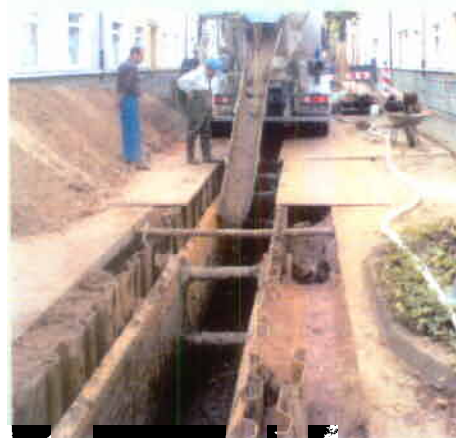
Baustelle in Düsseldorf: Einbringen des Flüssigbodens
