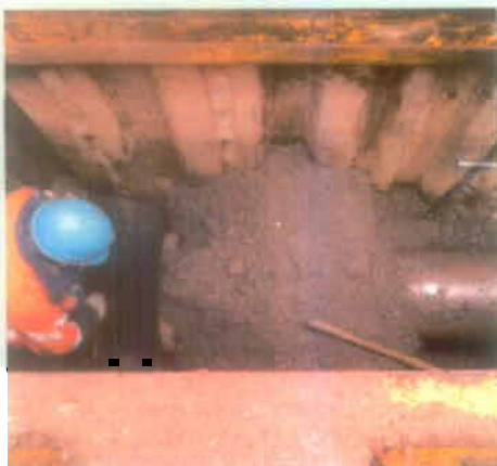
Abschottung mit plastischem Material im Bereich der letzten Muffe bis auf 30 cm über Rohrscheitel
