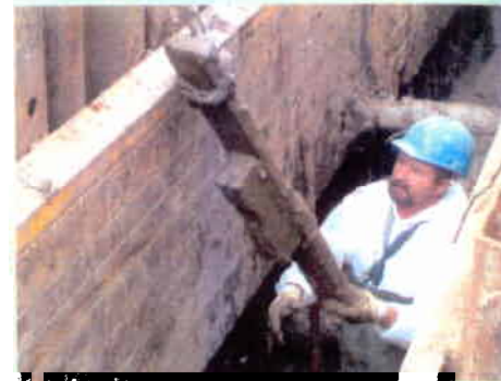
Ausbau der Auftriebssicherung nachdem Flüssigboden in der ersten Lage eingebaut wurde und die Auftriebswirkung abgeklungen ist.
