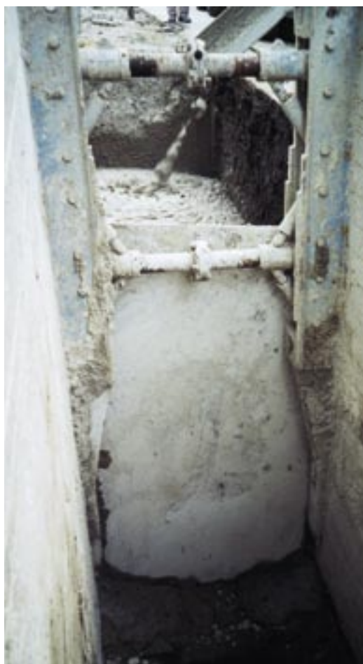
Bild links: 6 m 3 RSS-Flüssigboden ergießen sich über ein Fallrohr in den Graben und umschließen „lückenlos“ das Rohr.
