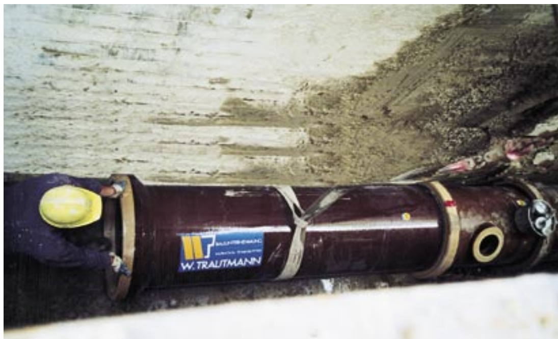
Das nächste Steinzeug-Hochlastrohr CeraLong wird im Graben verlegt; der Flüssigboden kann so nahtlos angefahren und eingebracht werden.
