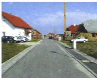
....und fertige Erschließungsstraße.
