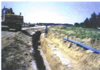
Baustelle mit Mono-Graben.....
