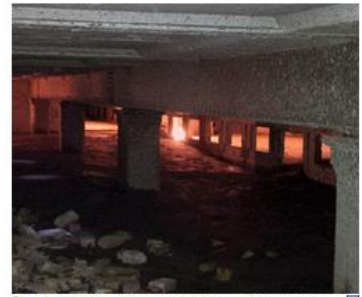
Über die Hälfte des Tunnels ist mit Flüssigboden verfüllt.
