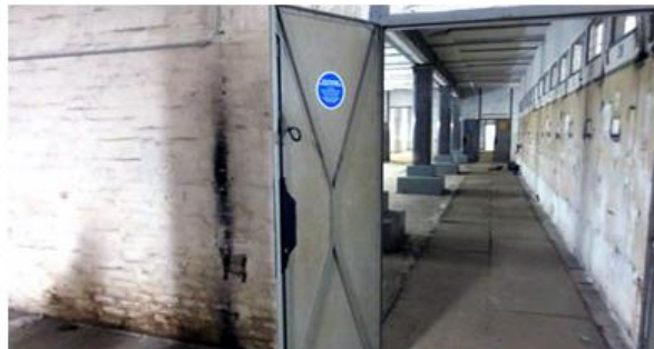
Bis 2012 konnten Führungen in den Bahnhofsrohbau unternommen werden.
