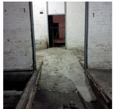
Beginn der Verfüllung mit Flüssigboden
