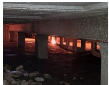
Beginn der Verfüllung mit Flüssigboden
