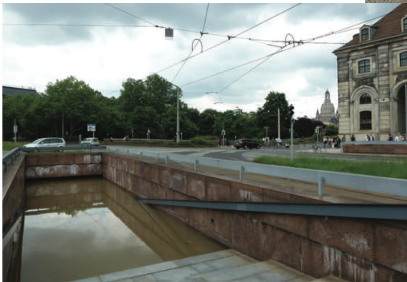
Nach der Elbeflut im Sommer 2013 war der Fußgängertunnel am Neustädter Markt für Wochen geflutet. . Foto: Joachim Renne
