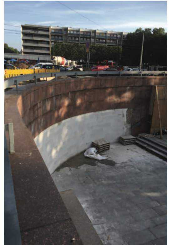
Vor der Verfüllung wurde der Tunnel beidseitig mit Wänden zugemauert. Foto: FiFB Leipzig
