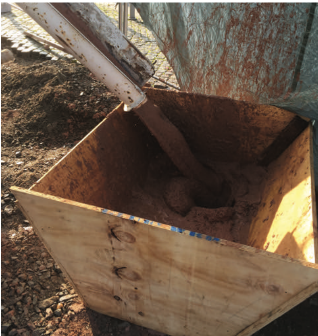
Über etliche Einfüllstützen wurde der RSS-Flüssigboden eingeleitet. (l.) Im Tunnel ist die Kabeltrasse sowie der sich langsam ausbreitende Flüssigboden zu sehen. Fotos: FiFB Leipzig
