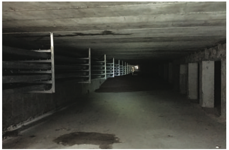
Über etliche Einfüllstützen wurde der RSS-Flüssigboden eingeleitet. (l.) Im Tunnel ist die Kabeltrasse sowie der sich langsam ausbreitende Flüssigboden zu sehen. Fotos: FiFB Leipzig
