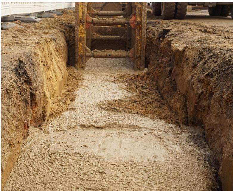
Graben verfüllt mit RSS Flüssigboden®
