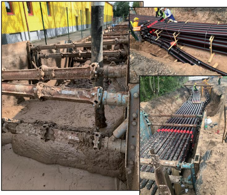
Graben verfüllt mit RSS Flüssigboden®
