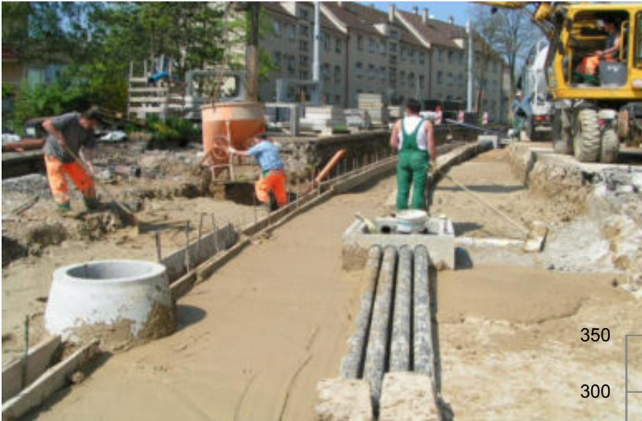
Beispiel einer Bodenplatte aus RSS Flüssigboden unter einem Stadtbahngleis in Stuttgart - Zuffenhausen
