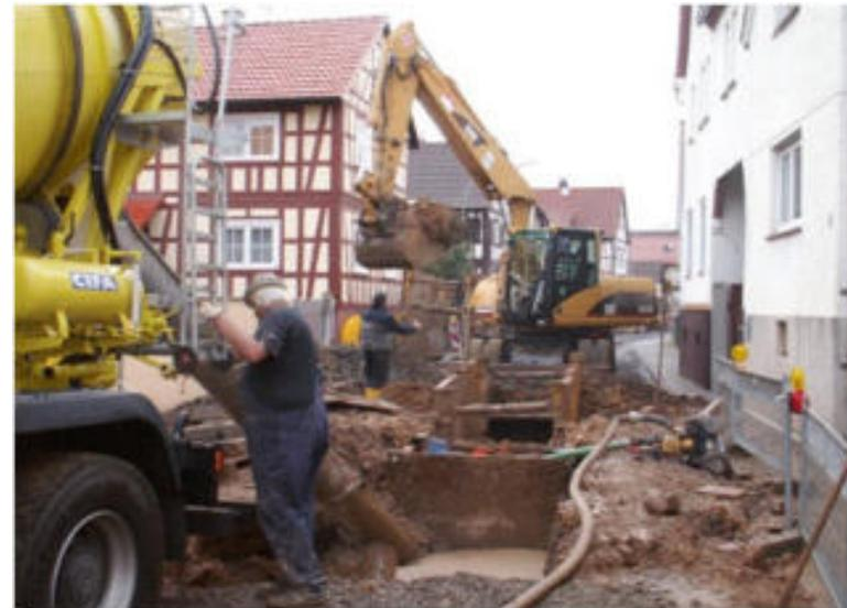
**Taktbauweise statt langer offener Gräben:** kurze getaktete Bauweise, ermöglicht durch gezielt eingestellte und technologisch relevante Eigenschaften von Flüssigboden **(Ist in einer angepassten Form auch bei Erdkabeln möglich!)**
