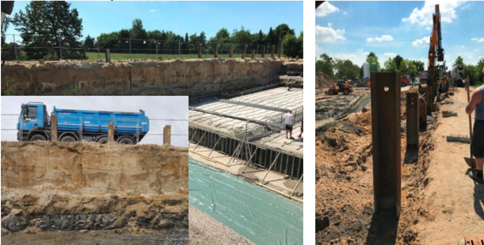
RSS<sup>®</sup> Wand als dichter Baugrubenverbau zur Substitution der rückverankerten, dichten Spundwand ohne verbleibende Bewehrung
