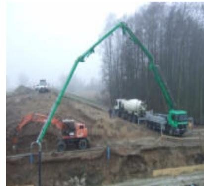
**Technologische Eignung z.B. für die Verfüllung per Betonpumpe**
