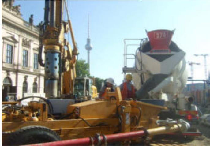
Überschneidende Bohrpfehlwände mit besonders hoher Tragfähigkeit bei zusätzlicher Bewehrung und hoher Relaxation
