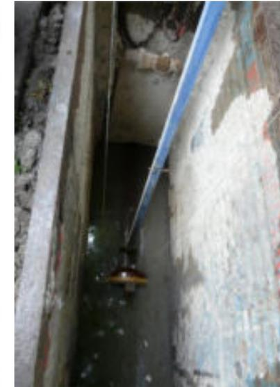
**Neue Technologien** wie z.B. die schwimmende Verlegung im Grundwasser mittels speziell eingestelltem Flüssigboden auf der Grundlage einer gesonderten Nachweisführung und Planung
