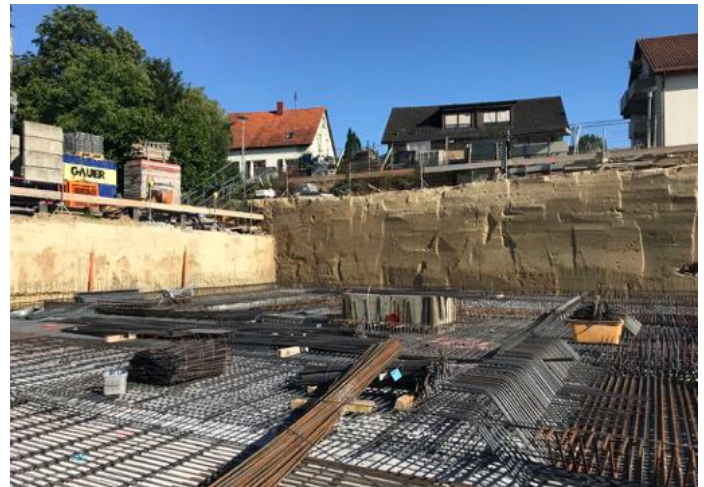
Verfüllung einer Baugrubenwand mit RSS-Flüssigboden und das fertige Ergebnis nach dem Aushub der Baugrube. Fotos: FiFB Leipzig
