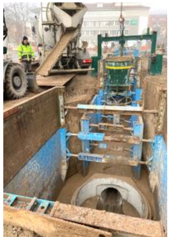
Baustelle Tübingen: Einbau eines Mischwasserkanals in RSS-Flüssigboden. Foto: Olaf Stolzenburg
