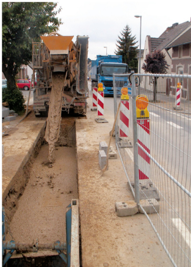
Kein Verdichten - schmale Baustellen, ohne Vollsperrung
