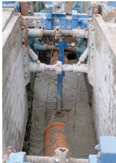
schwimmende Rohrverlegung
