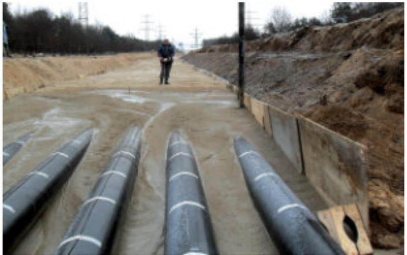
Frankfurt-Kelsterbach: Im Auftrag der Amprion GmbH wurde im Jahr 2009 eine 380 kV GIL-Höchststspannungsleitung in RSS-Flüssigboden eingebettet. Foto: FiFB Leipzig
