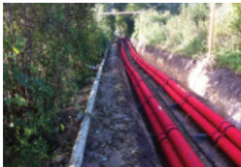
Um den Flächenverbrauch der Kabeltrasse zu minimieren ist – im Gegensatz zur platzzehrenden Nebeneinanderverlegung – die platzsparende Dreiecksverlegung ein optimaler und gut umsetzbarer Weg. Kabel in Dreiecksverlegung, gebettet in thermisch stabilisierendem RSS Flüssigboden TS, sind belastbarer als in Sand nebeneinander verlegte Kabel und haben eine bessere Wärmeableitung. Fotos + Grafik: FiFB Leipzig
