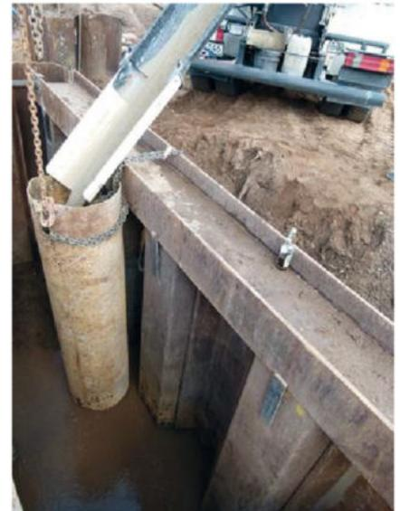
Verfüllung einer Baugrube mittels Kontraktorverfahren
