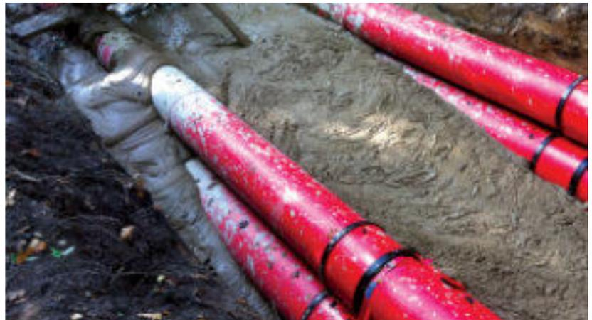
Audorf: Im Auftrag der Tennet TSO GmbH wurden im Jahr 2013 220 kV Erdkabel in Dreiecksverlegung in RSS-Flüssigboden eingebaut. Foto: FiFB Leipzig
