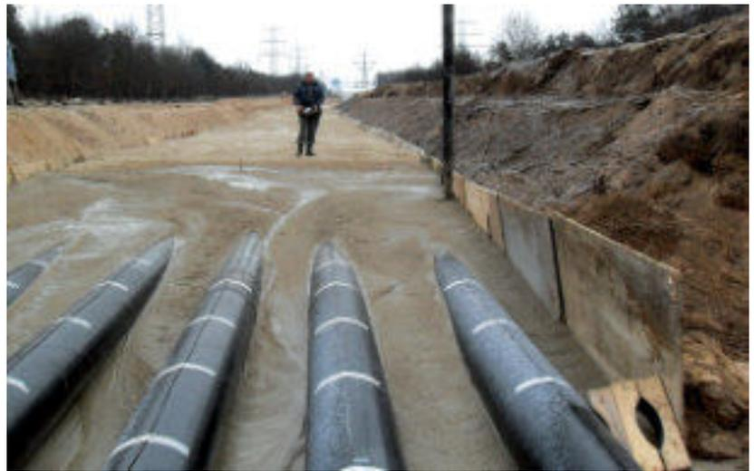
Frankfurt-Kelsterbach: Im Auftrag der Amprion GmbH wurde im Jahr 2009 eine 380 kV GIL-Höchstspannungsleitung in RSS-Flüssigboden eingebettet. Foto: FiFB Leipzig
