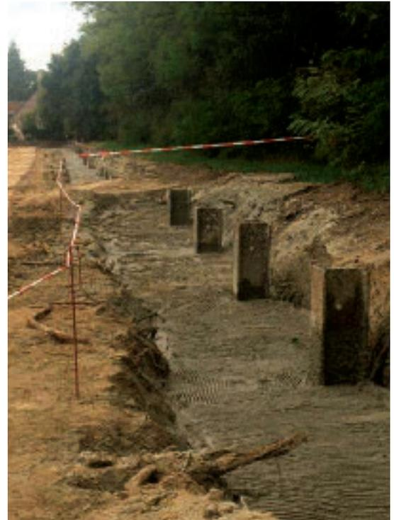
*Frisch verfüllte Träger-Flüssigbodenwand. Foto: Ingenieurbüro LOGIC*
