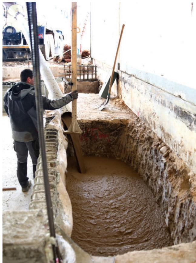
Erfahrungen mit der Herstellung von RSS-Flüssigboden und seinem Einbau konnte das Unternehmen bereits 2016 sammeln, als der Fußgängertunnel am Neustädter Markt nach dem Hochwasser im Sommer 2013 in Verbindung mit erforderlichen Sanierungsvorhaben verfüllt werden musste.
