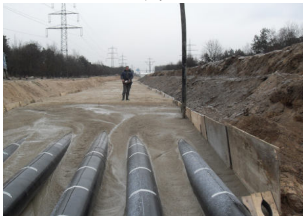
Zukunftsweisend: Erdkabelverlegung in Flüssigboden.
