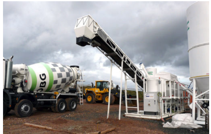
Vor Ort wird der Flüssigboden hergestellt. Mit diesem werden dann die Kombi-Schächte und alle Leitungen hohlraumfrei eingebettet und umhüllt. Eine lange Lebensdauer wird so garantiert.
