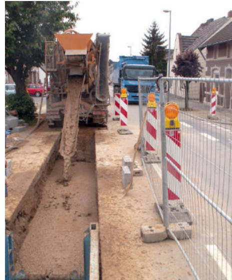
Durch den Einsatz von Flüssigboden kann eine Aufgrabung wieder in ihren ursprünglichen, ungestörten Zustand zurückversetzt werden – jegliche Schäden an Straße und Rohrleitungen gehören dann der Vergangenheit an.
