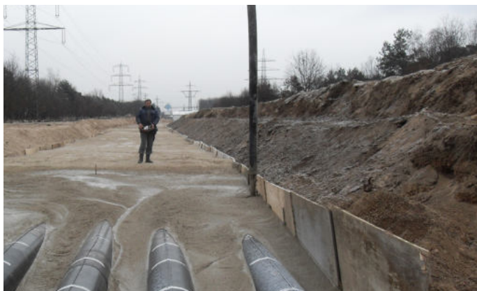
Verlegung von 400 kV Leitungen am Frankfurter Flughafen (Deutschland). Hier wurden gasisolierten Übertragungsleitungen (GIL) in RSS Flüssigboden eingebettet. Foto: FiFB
