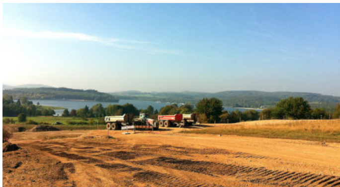
Am Bostalsee entsteht ein großer Ferienpark. Auftraggeber und Planer suchten ein innovatives Konzept zur Erstellung der Infrastruktur. Die Kombi-Trasse erfüllte alle Anforderungen.
