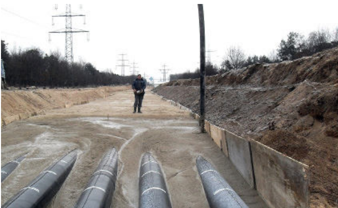
Nahtlos umschließt der Flüssigboden alle Rohre und Leitungen. Hier werden zum Beispiel Hochspannungskabel in der Nähe von Frankfurt am Main in Flüssigboden verlegt.
