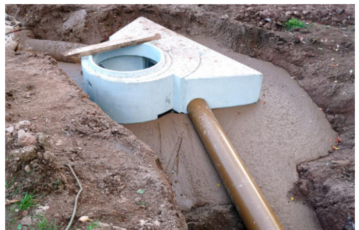
Vor Ort wird der Flüssigboden hergestellt. Mit diesem werden dann die Kombi-Schächte und alle Leitungen hohlraumfrei eingebettet und umhüllt. Eine lange Lebensdauer wird so garantiert.
