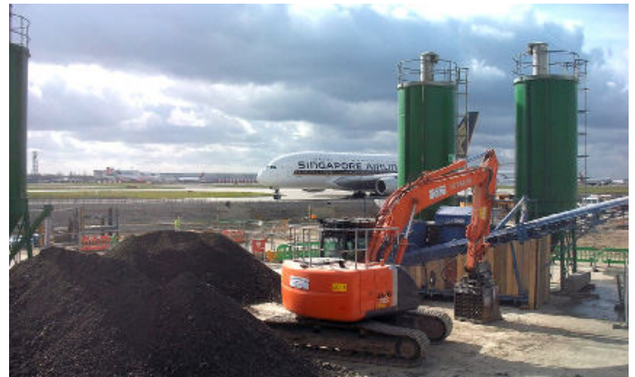
Die für die Herstellung von Flüssigboden entwickelte Technik ist in der Lage, das Verfahren in all seinen Unterschieden zur reinen Misch- und Betontechnologie korrekt umzusetzen.
