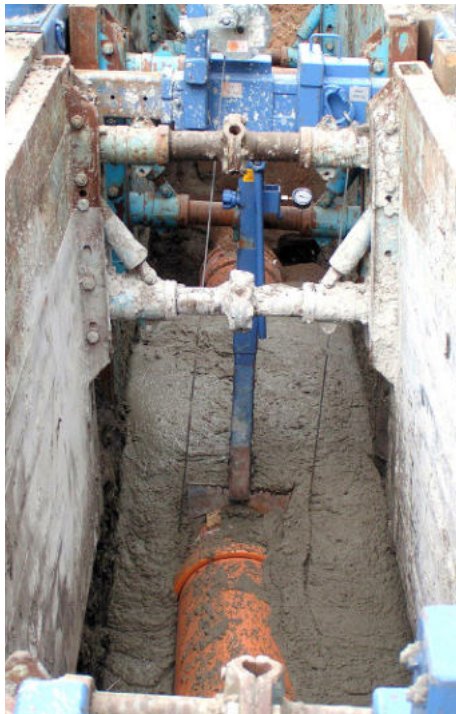
Die Lagesicherung von unterirdischen Bauwerken oder Rohrleitungen wird mittels speziell entwickelter technischer Hilfsmittel gewährleistet.
