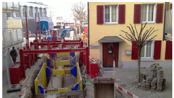
Hier geht es eng zu: Die Baustelle im Lachner Dorfkern. Foto: FiFB Leipzig
