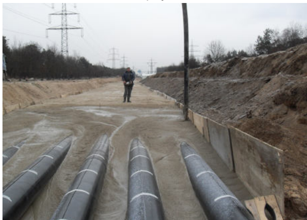
Zukunftsweisend: Erdkabelverlegung in Flüssigboden. Foto: PROV
