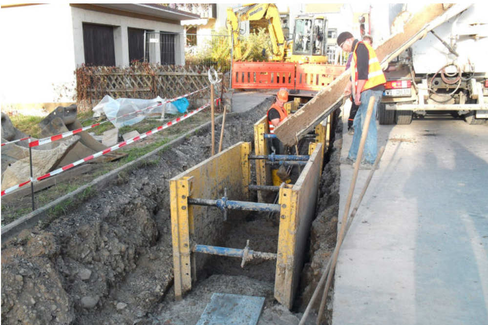
Auf gute Erfahrungen bei der Erdkabelverlegung in Flüssigboden kann Die Bau GmbH verweisen. Das Flüssigbodenverfahren wurde dabei erfolgreich angewandt. „Es hat nicht nur technisch sondern auch durch viele weitere Begleitumstände wie geringerer Bauzeit, weniger Immissionen und der damit geringeren Belastung der Anwohner überzeugt“, so Jürgen Eckert nach Abschluss dieser Baumaßnahme. Foto: Die Bau GmbH
