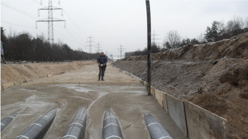
Verlegung von 400-kV-Leitungen am Frankfurter Flughafen. Hier wurden gasisolierten Übertragungsleitungen (GIL) in RSS Flüssigboden eingebettet. Foto: FiFB
