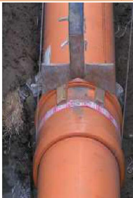
Setzen eines KG DN 500 Rohres im untersten Bereich des Rohrgrabens während Erstaushub „Holländische Bauweise“
