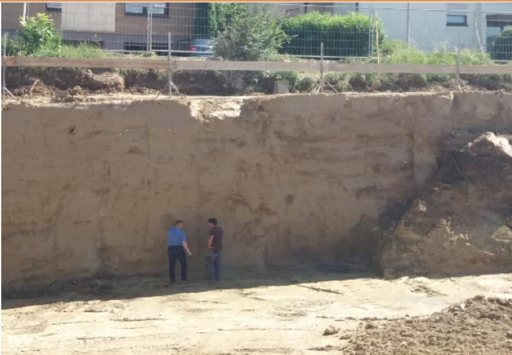
**Wasserdichte Baugrube:** als RSS® Wand in Kombination mit einer Bodenplatte, auch aus RSS® Flüssigboden zur Erstellung einer wasserdichten Baugrube samt aller dafür erforderlichen Berechnungsmethoden und Nachweisführungen
