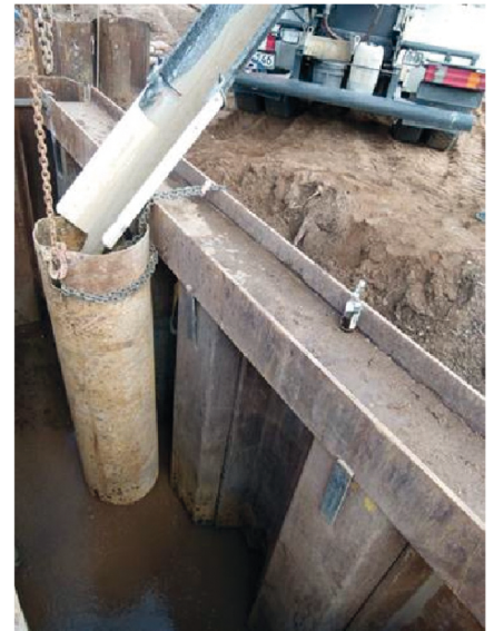
Verfüllung einer Baugrube mittels Kontraktorverfahren
