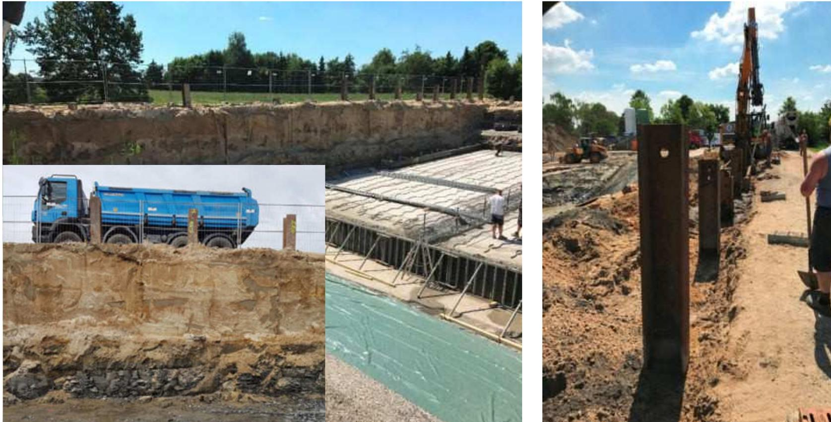
Mur RSS® en tant que blindage étanche de fosse d'excavation pour remplacer un mur de palplanches scellé et ancré à l'arrière sans renfort résiduel.
