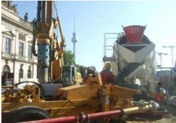
Parois de pieux forés sécants avec une capacité portante élevée avec un renforcement additionnel et une grande détente.
