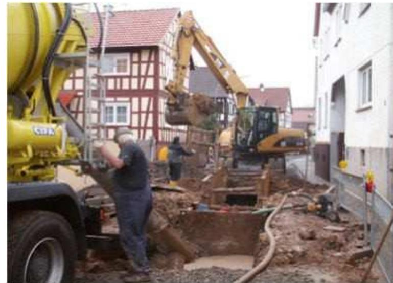
**Méthode de construction par cycles au lieu de longues tranchées ouvertes** : méthode de construction à cycle court, rendue possible par des propriétés ciblées et technologiquement pertinentes du sol liquide (aussi possible pour la pose de câbles souterrains sous une forme adaptée)
