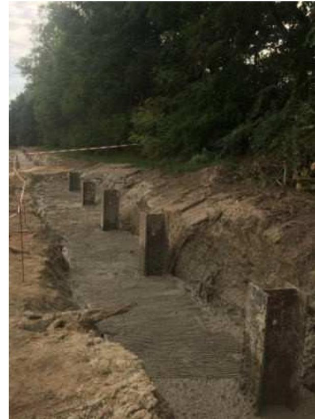
Mur RSS® comme blindage étanche de fosse d'excavation, complété par une dalle de sol étanche en sol liquide RSS®. Pas besoin d'étanchéité, de paroi de palplanches et récupération du renforcement.
