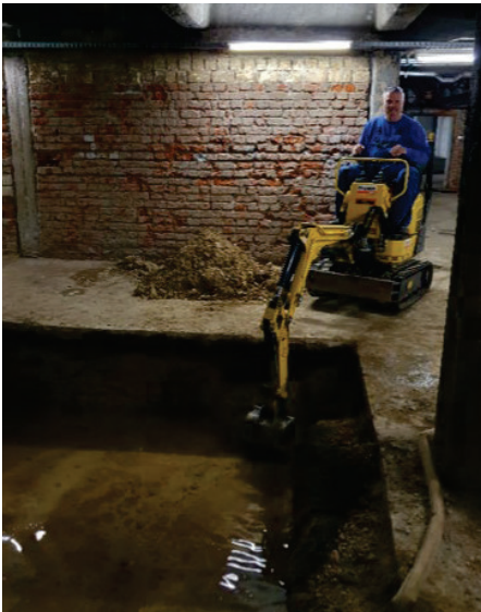
Abbildung 3: Aushub im Keller Fa. Bernd Tinat Tinat Leipzig, die Sohle der Gründungsebene von -80cm auf -130cm tiefer geschachtet.
